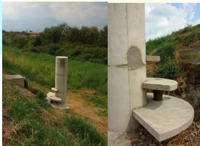
Se construyó la estructura de disipación de energía y la cañuela en la descarga al Canal Norte, para no socavar el jarillón cuando los niveles del agua del Canal estén bajos y se le realice mantenimiento a la bomba. EPSA instaló el contador de energía e inició el suministro de la misma. El contratista realizó las pruebas y puesta en marcha de los equipos de bombeo, y realizó la capacitación en operación y mantenimiento de
