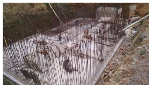
TANQUE DE ALMACENAMIENTO: Armado de acero
