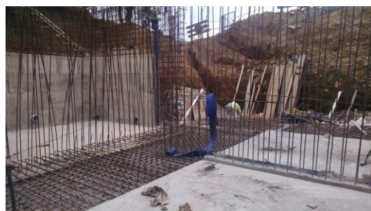
TANQUE DE ALMACENAMIENTO: Armado de acero
