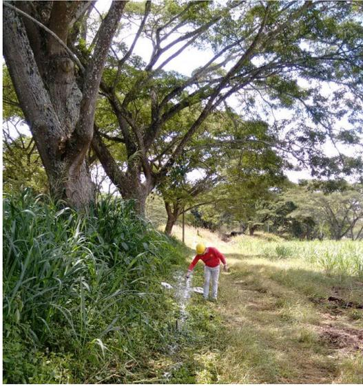
Demarcación con cal, para el inicio de las excavaciones
