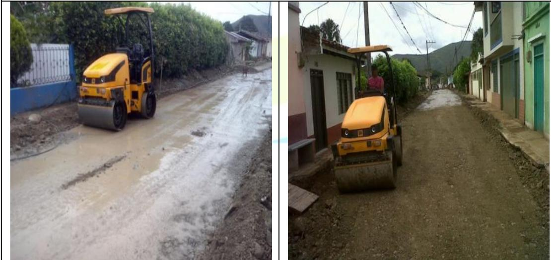
CONFORMACIÓN DE SUB-BASE GRANULAR TIPO ROCAMUERTA PARA VIA DE LA CARRERA 7
