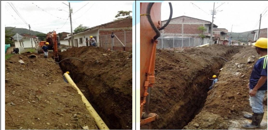
**EXCAVACIÓN PARA INSTALACIÓN DE TUBERÍA PVC SANITARIA**
