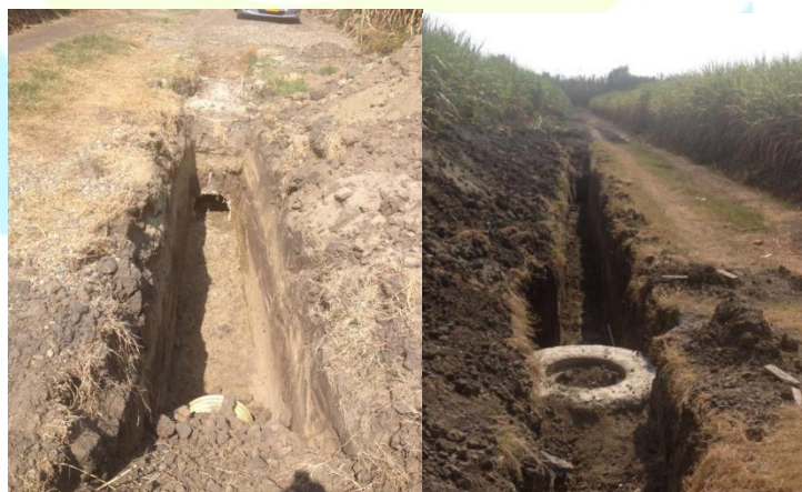
Construcción del colector final al Rio Párraga después de la Planta de tratamiento.
