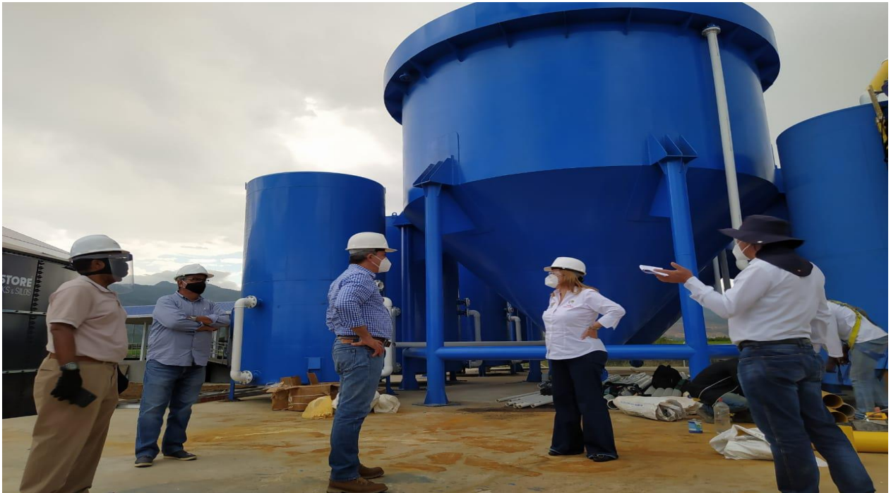
Foto Vallecaucana de Aguas / Visita inspección obra Yumbo
