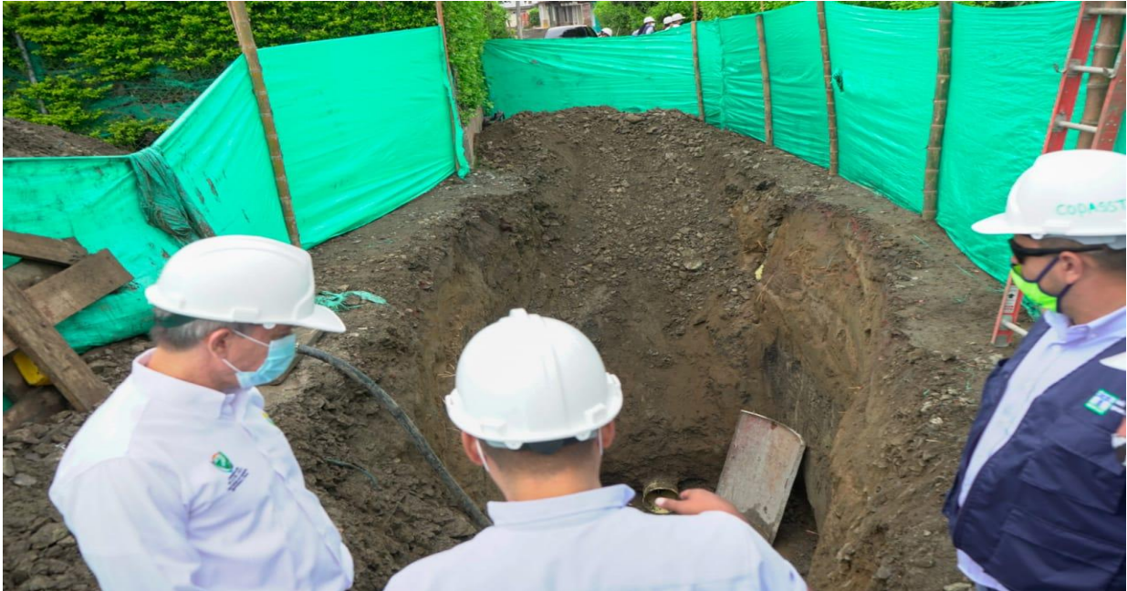
Foto Vallecaucana de Aguas / obra alcantarillado de Guabas- Guacarí
