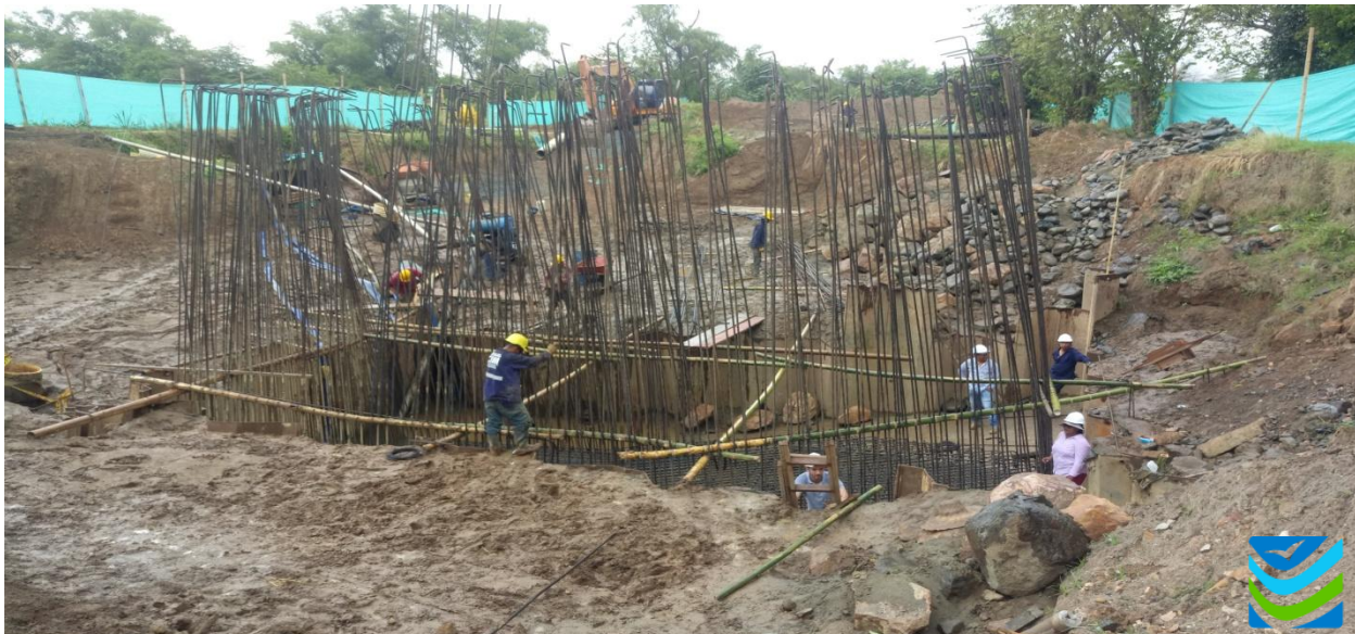
Foto /Vallecaucana de Aguas-Alcantarillado de Yotoco
