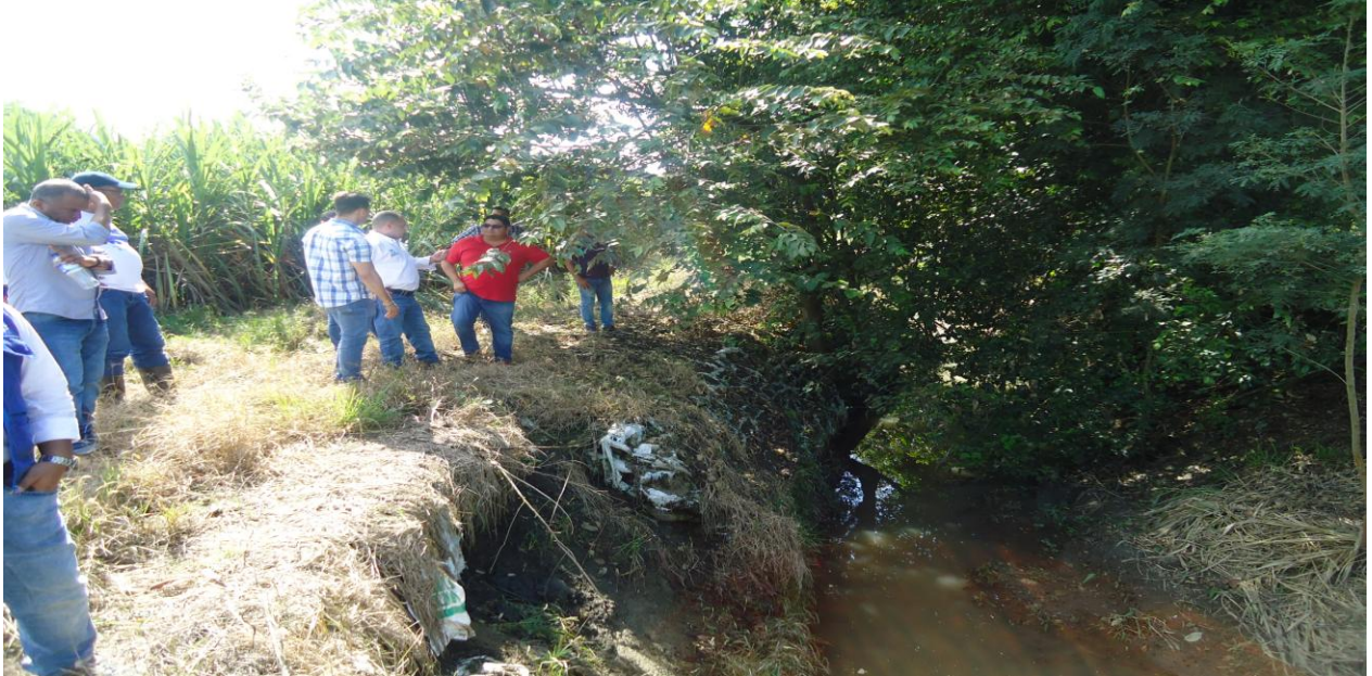
Foto Vallecaucana de Aguas/Visita Técnica obras Buga – Calima, El Darién
